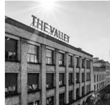
Die alten Fabrikgebäude in Kempthal neu benannt
